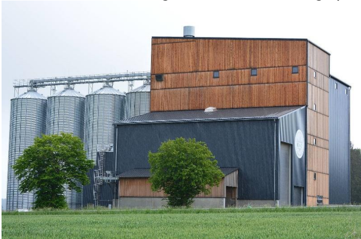
Abb. A. 4: Das BregO-Lagerhaus in Harenzhofen bei Velburg.
